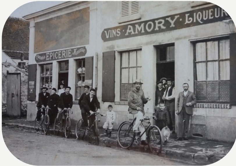
Angle Grande Rue et rue d'Hargeville
