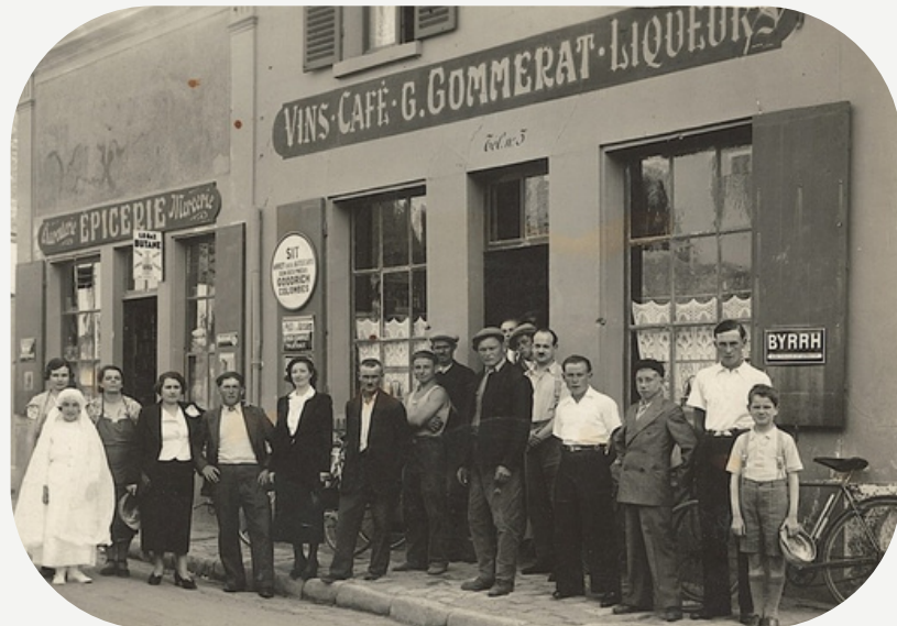
Angle Grande Rue et rue d'Hargeville
