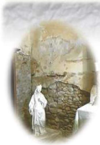
On constate notamment des infiltrations d'eau, une humidité générale de l'édifice provoquées par des mouvements dans la charpente, une porosité de la toiture, des fissures et des décollements d'enduits et de parements.
