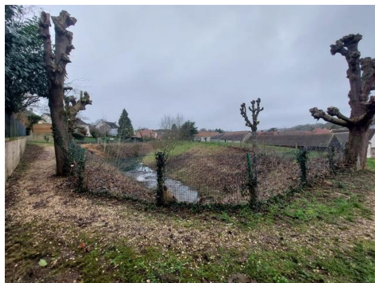
Bassin de rétention
