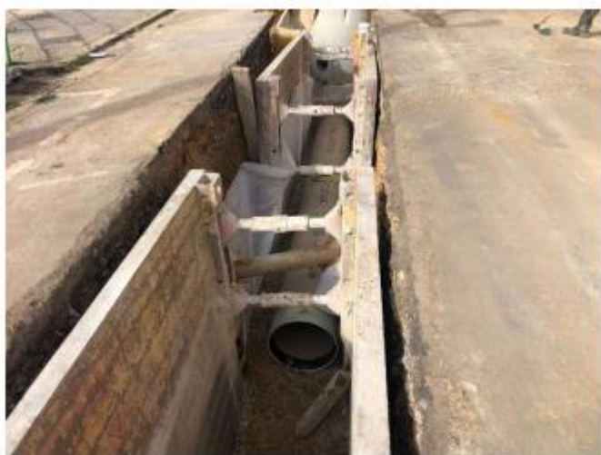
Pose réseau EP – Grande Rue (RD158) - JUM
