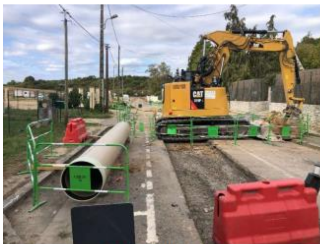
Mise en sécurité le soir
