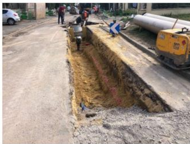
Pose réseau EP – Grande Rue (RD158) - JUM
