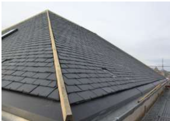
Arête de toit et grille de ventilation
