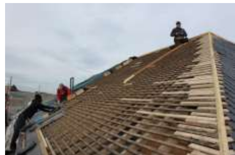
Remplacement des liteaux défectueux
